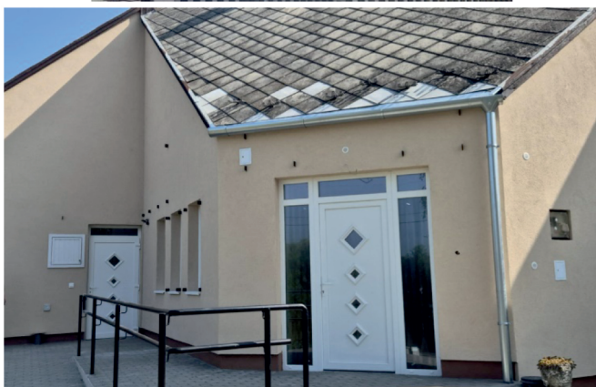
Régi bölcsőde épülete energetikai korszerűsítést követően
