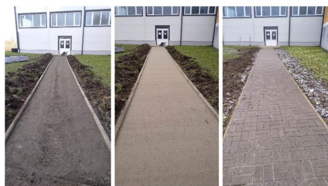
A tornateremhez vezető járda felújításának folyamata
