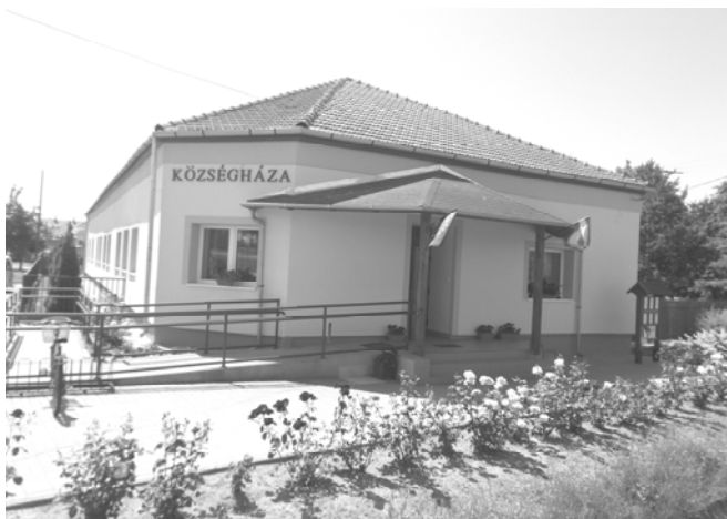
A felújított, megszépült hivatal épülete
