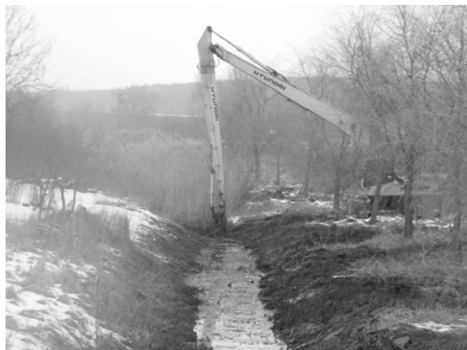
Megkezdődött a bujáki patak felújítása
