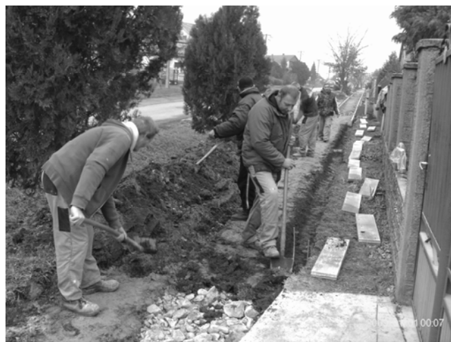
Járda felújítás az Ady Endre úton
